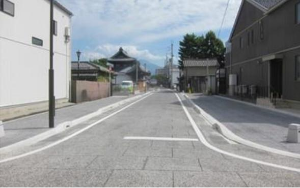
舗装表面に模様をデザインできるように工夫した保水性舗装の施工例。道路としての機能だけでなく、環境にも景観にも配慮し、地域の特徴を活かした空間づくりを担う一つとしての活用が期待される。
