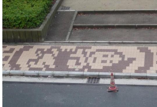
保水性ブロックの設置例で、行政とまちづくりの会の協働により施工した。地域の歴史に因んだデザイン（相撲）に施工されている。市と住民との間で協定が結ばれ、整備された歩道には、住民が打ち水を実施している。
