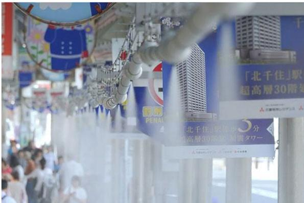
商業施設のアーケードに、微細ミストを設置した例。駅からの出口や店舗が立ち並ぶ通路沿いに設置されている。気候に応じて遠隔にて起動、停止を制御している。
