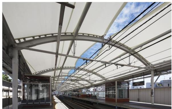
駅の改修に伴い、ホーム全体を覆う膜構造の屋根を設置した例。金属屋根などと比べると、膜屋根は屋根の下を明るく保つことで照明の電力を削減できる。また、防汚効果が高い光触媒膜材で、高い日射反射率を維持することができる。
